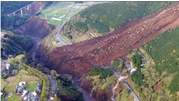
写真-2 阿蘇大橋地区斜面崩壊 (国道57号寸断, 国道325号阿蘇大橋落橋) (出典: 国土交通省九州地方整備局資料)
