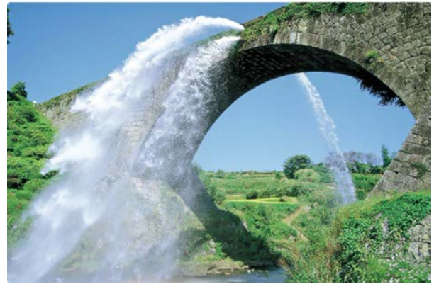
写真-1 通潤橋 (出典：山都町役場ホームページ)
