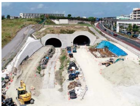
トンネル及び抗口部
