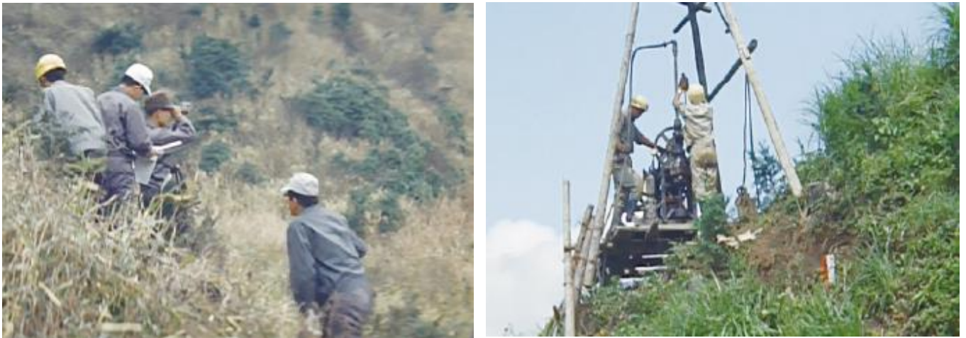
写真－1 現地踏査・地質調査実施状況
