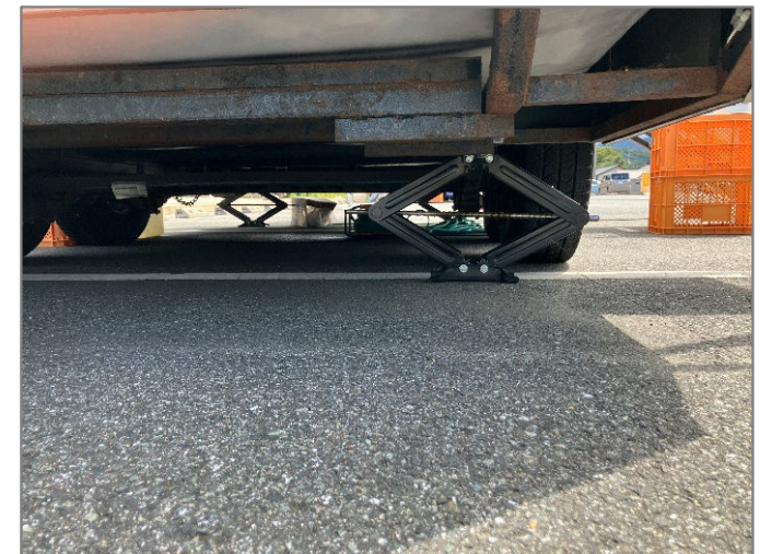
▲トイレトレーラーのジャッキ基礎
