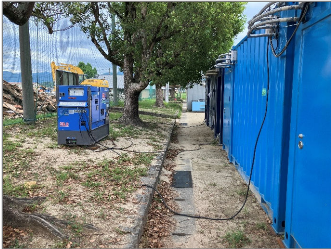
▲発電機にコンテナトイレ2基を接続
