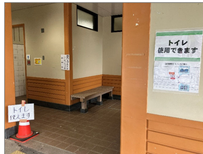
▲トイレは復旧済み(調査日時点)
