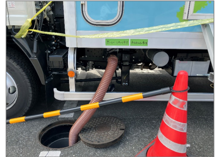
▲トイレトレーラーから下水道に接続
