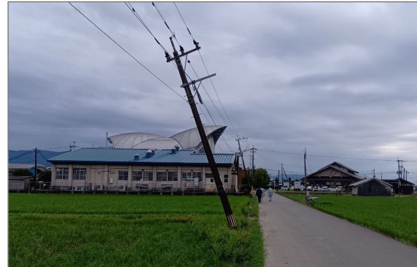
▲傾斜した電柱②
