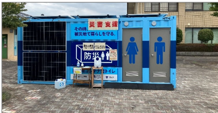
▲インターロッキング上にコンテナを直置き
