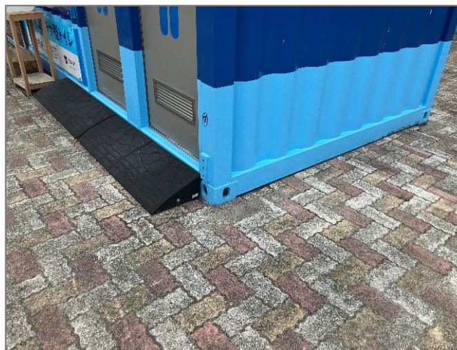
▲段差プレート設置
