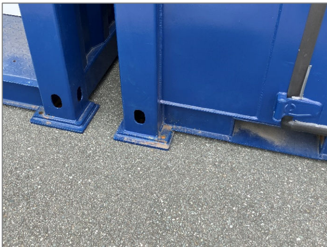
▲アスファルトにコンテナを直置き
