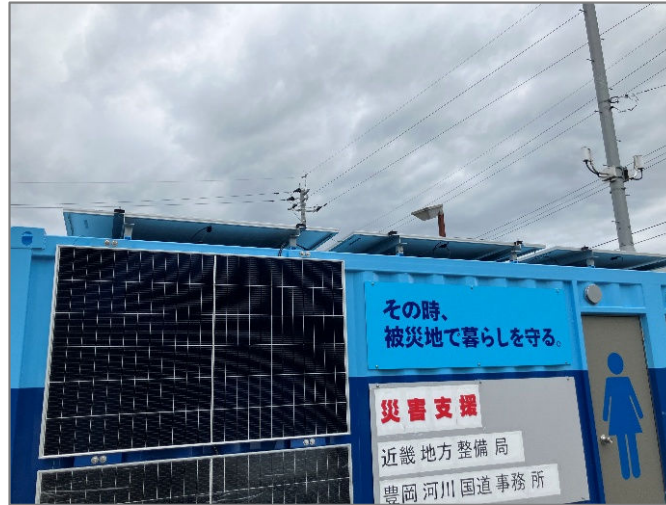
▲コンテナ壁面・屋根にソーラーパネル
