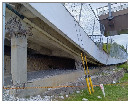
▲張出し部の崩壊(道の駅竜北付近)
