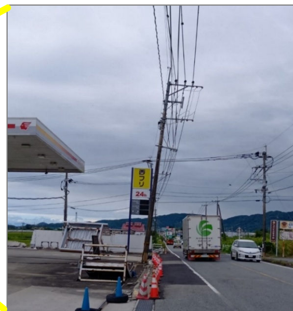
▲傾斜した電柱(国道3号沿い)
