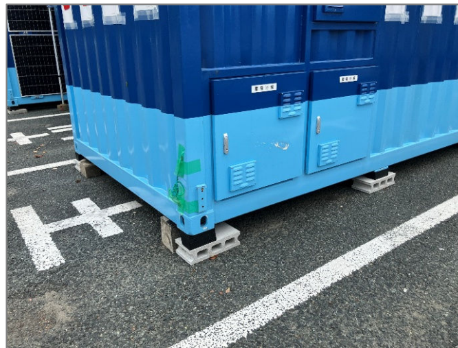
▲コンテナ基礎としてブロック設置
