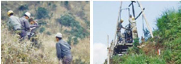
写真-1 現地踏査・地質調査実施状況
