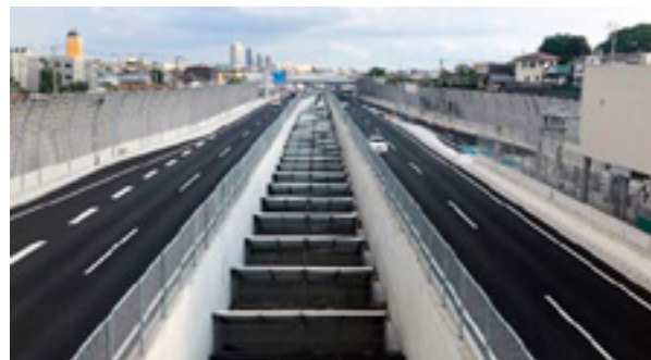
写真-6 開通後の外環千葉県区間
