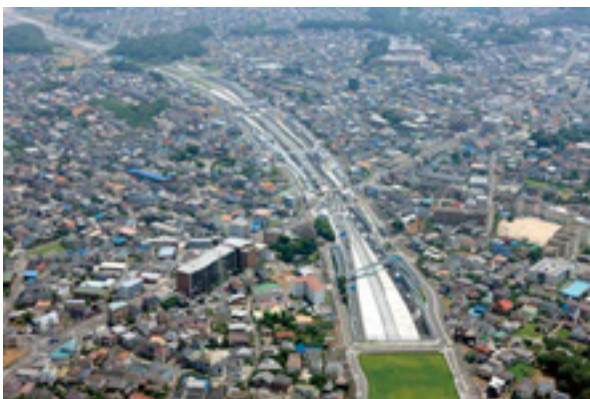
写真-1 外環千葉県区間 松戸市（手前側）から市川市へ
