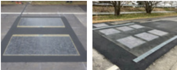
新技術導入促進方針計画に基づく路面太陽光発電技術の実証試験の実施
