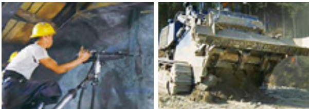
写真-2 山間部の地盤掘削・トンネル工事状況
