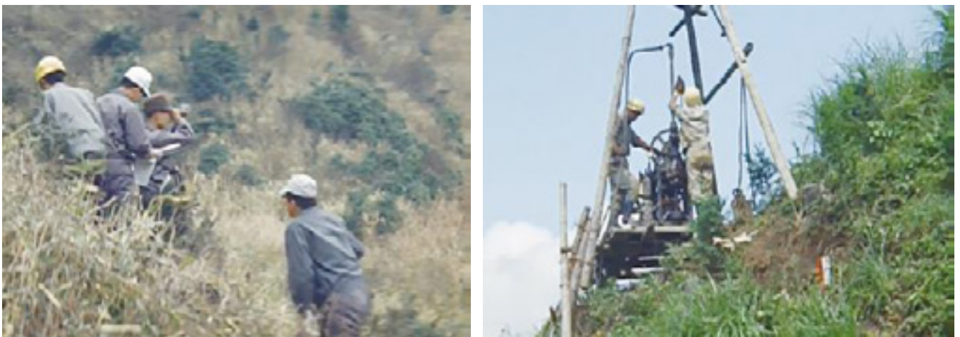
写真－1 現地踏査・地質調査実施状況
