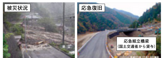
写真-2 応急組立橋による迂回路設置
