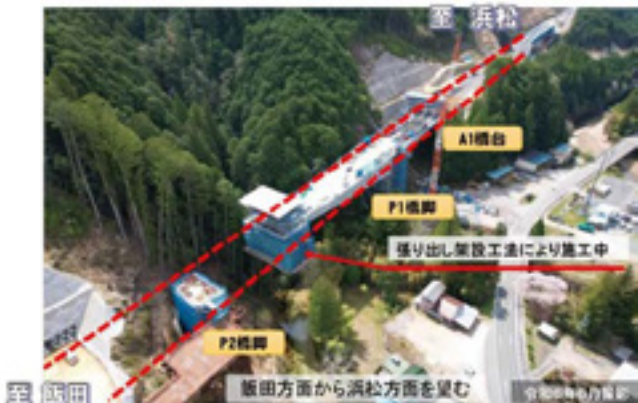
図-6 三遠道路8号橋施工状況
