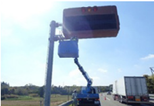
高所作業車を用いた点検
