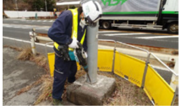
点検を行うための基盤掘削
