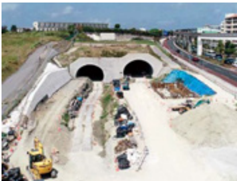
トンネル及び抗口部
