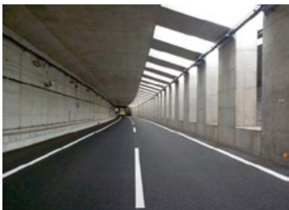
写真-5 外環千葉県区間の掘割スリット構造
