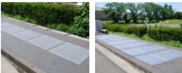
福島県大熊町の役場駐車場における路面太陽光発電技術の実証
