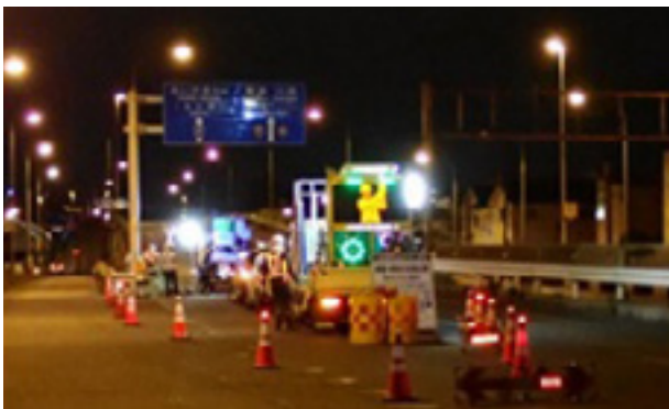
夜間作業での点検
