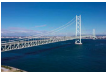
E28神戸淡路鳴門自動車道「明石海峡大橋」
