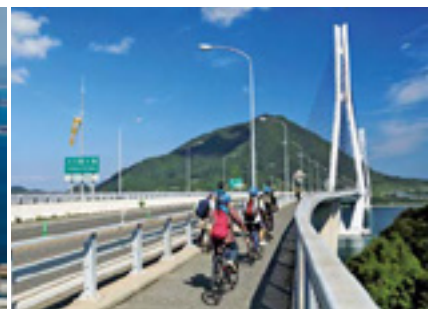
E76西瀬戸自動車道「多々羅大橋」
