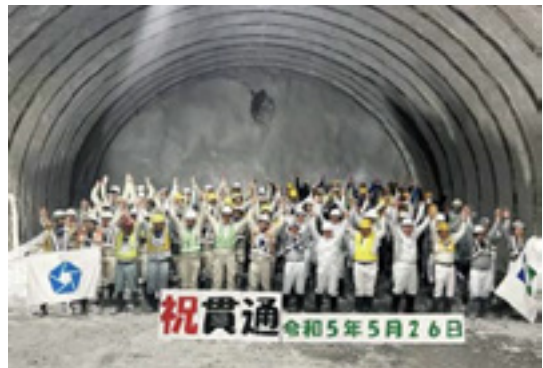
写真-1 青崩峠トンネル（仮称）貫通
