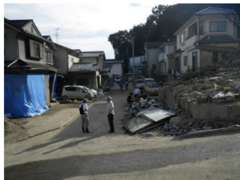
写真-16 復旧状況
