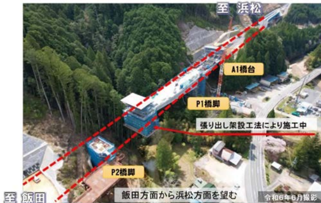
図-6 三遠道路8号橋施工状況
