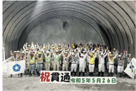
写真-1 青崩峠トンネル（仮称）貫通
