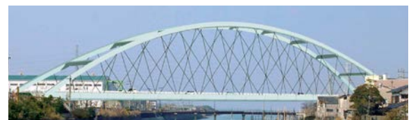
写真-1 諏訪川橋
