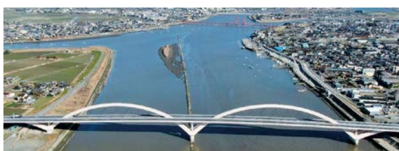
写真-3 有明筑後川大橋
