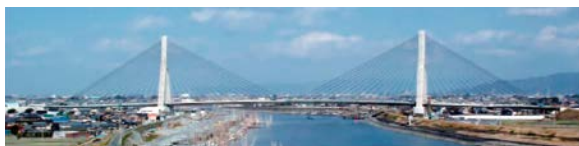
写真-2 矢部川大橋
