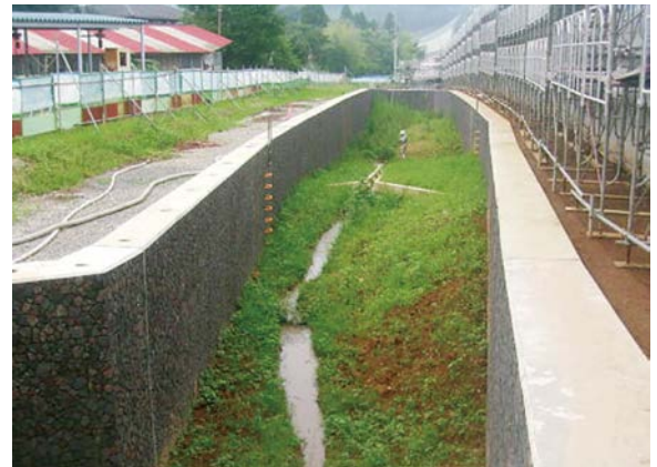
写真-5 付け替え水路
