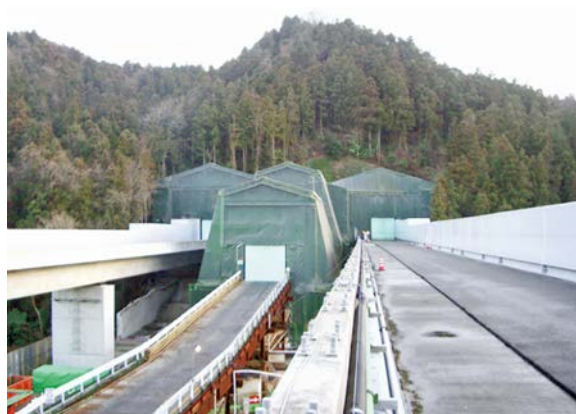
写真-4 トンネル坑口の防音屏
