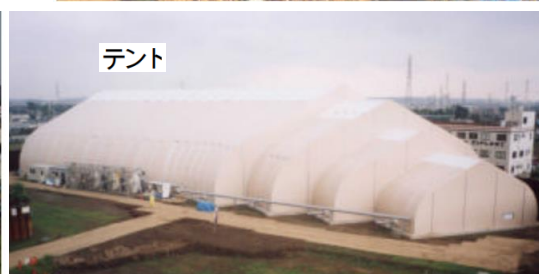
写真-2 掘削残土仮置き場
