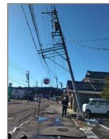
道の駅すずなり周辺で発生した電柱傾斜
