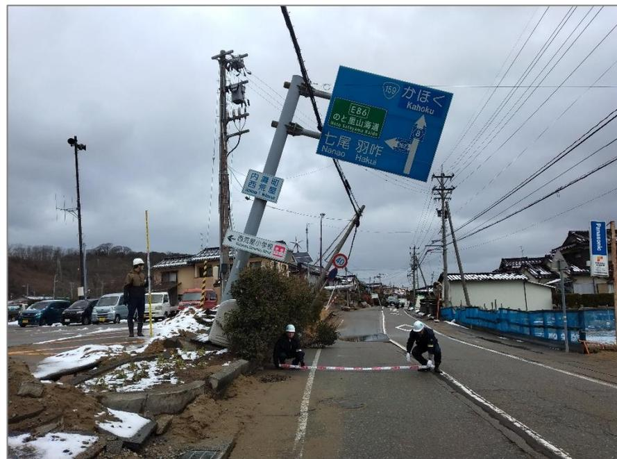
▲被災後：道路標識・電柱傾斜、噴砂
