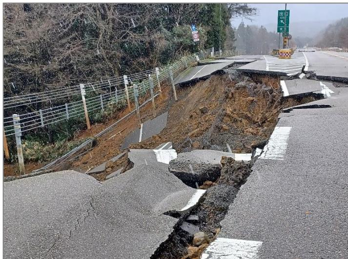
▲盛土の崩壊・路面の崩壊
