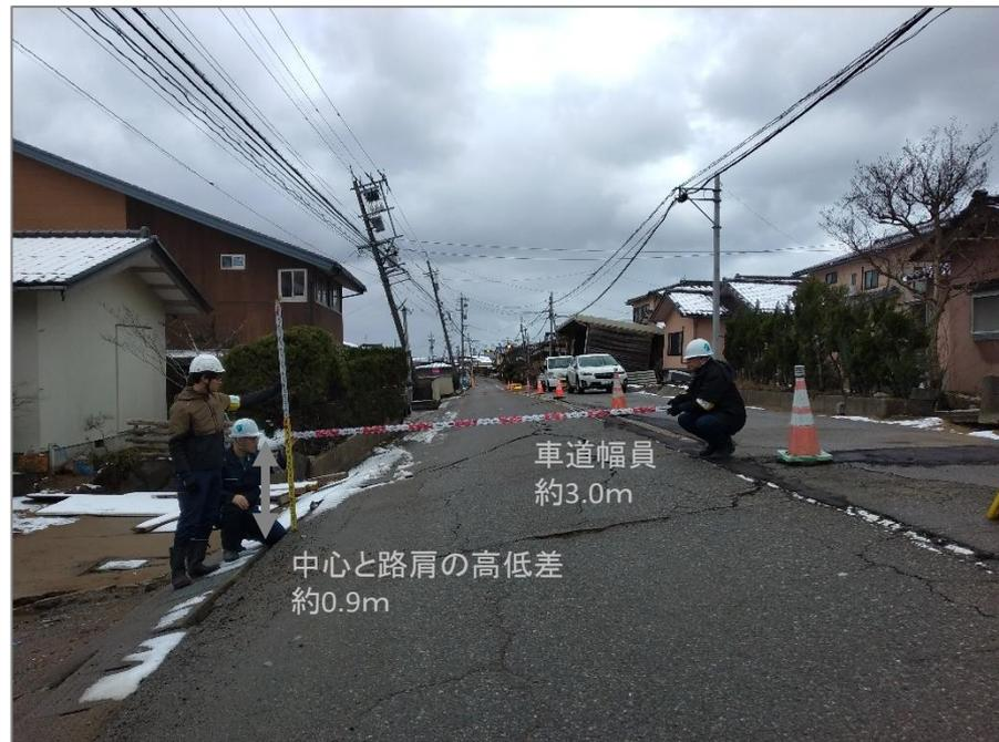
▲被災後:舗装の浮き上がり、傾斜
