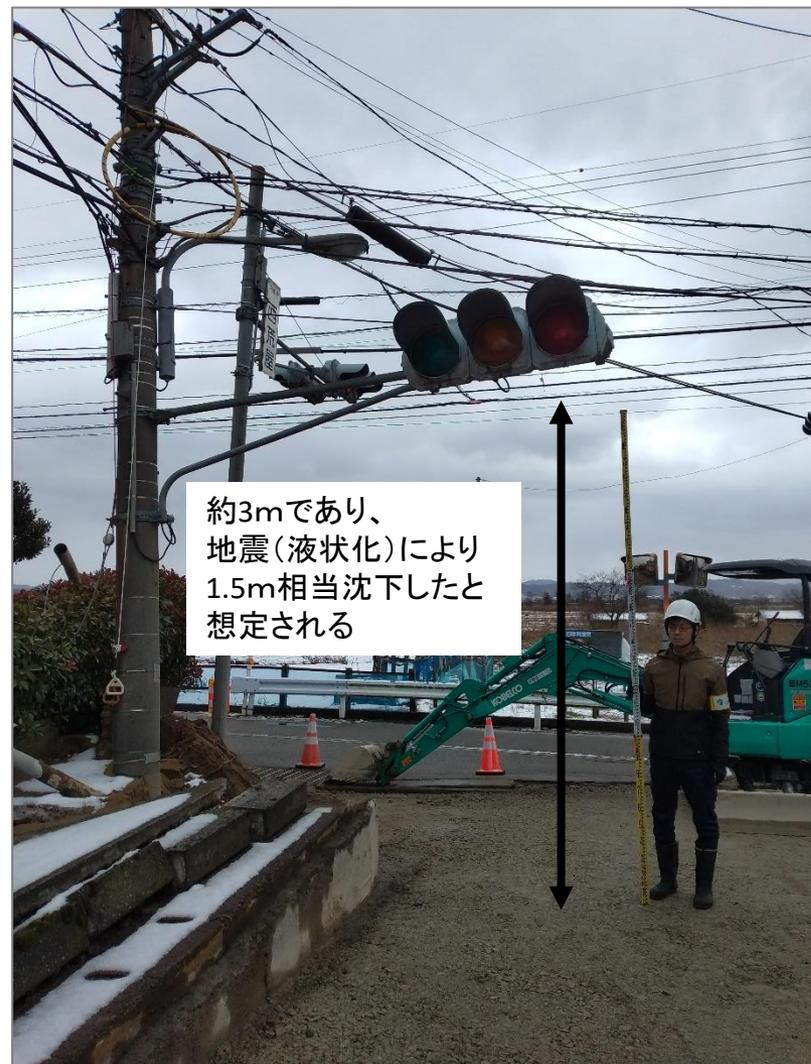
▲被災後:信号機 沈下
