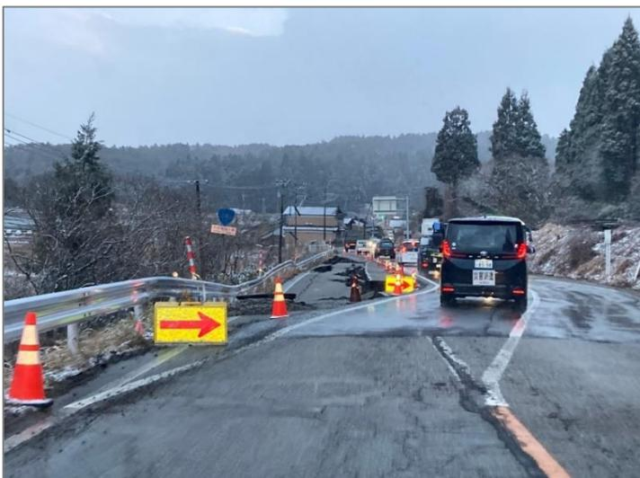
▲路面の沈下
