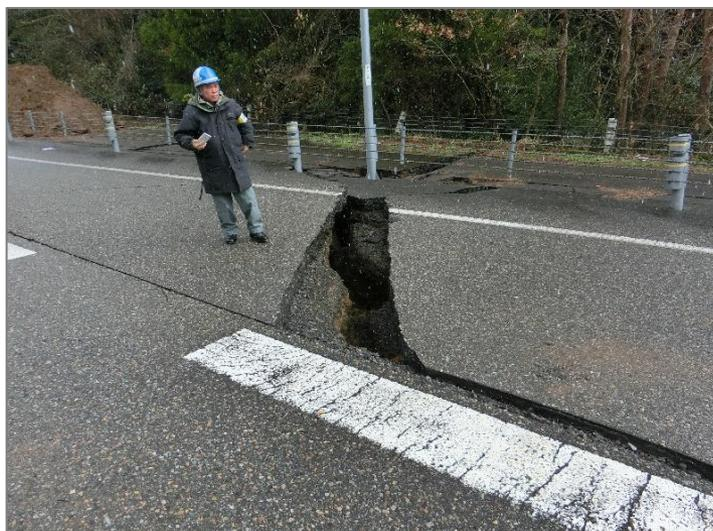
▲盛土の崩壊・路面の崩壊
