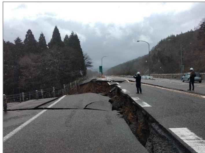
▲盛土の崩壊・路面の崩壊
