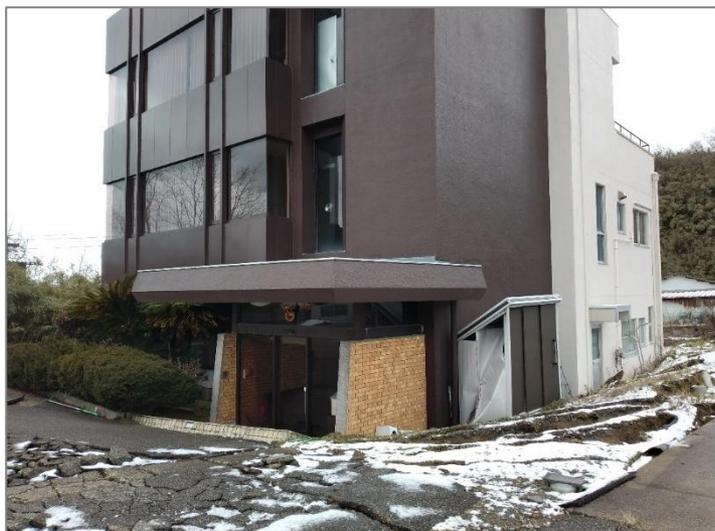
▲建築物の沈下
