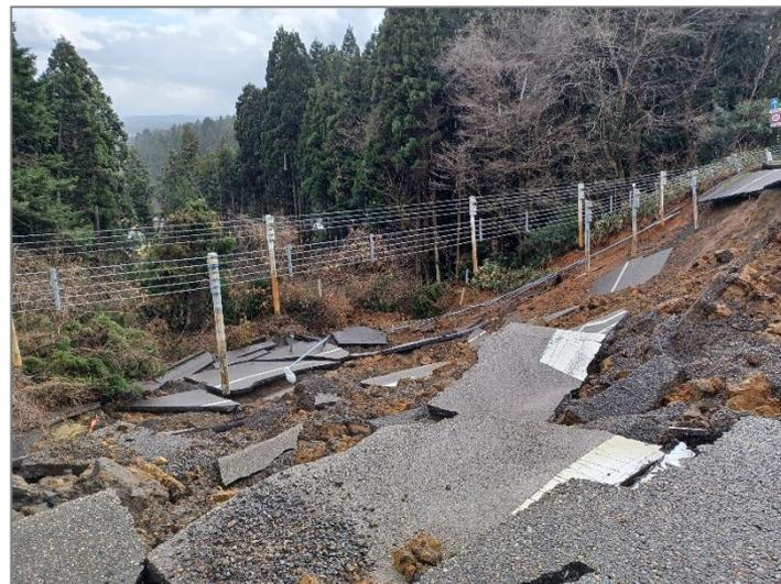
▲盛土の崩壊・路面の崩壊
