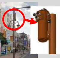
ソフト地中化用変圧器 | <ul style="list-style-type: none"> <li>✓ 2021年度仕様統一完了</li> <li>✓ 狹隘道路向け変圧器の開発にあたり、メーカー意見・要望を反映。作業性向上のため外形寸法など構造面や、性能試験等の仕様を統一化</li> <li>✓ 照明柱に設置することにより、地上変圧器が不要かつ低コストで整備可能</li> </ul> |
